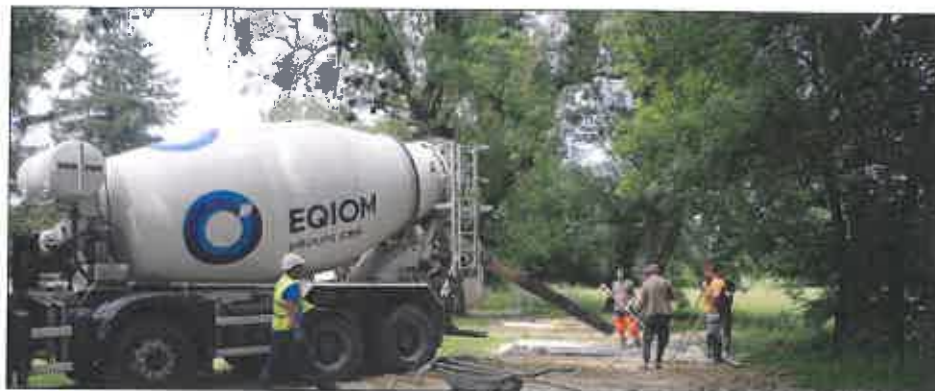
Réunion de chantier avec Alain et Morgan, de Lux, Étienne et Johan, de La Charmée, Daniel Morin, Vincent Obled et Denis Evrard, maires, Gérard Lardy et son petit-fils Antony, venu inspecter les travaux. Photo Jean-René MARGEZ
